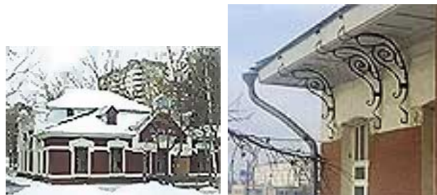
Рис. 15: Станция МОЖД Воробьёвы горы. Архитектор А.П.Померанцев. 1907 год Деталь станции Воробьёвы горы: карниз здания с металлическими кронштейнами (справа)
